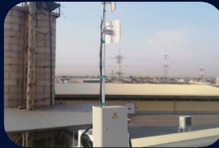
Модель в IP65 корпусе для наружного монтажа с направленными антеннами
